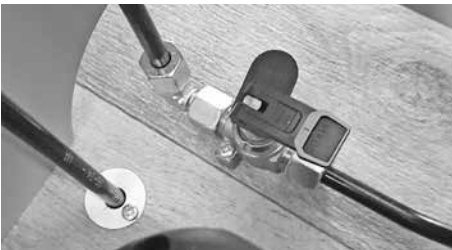
Absperrhahn Heizung
